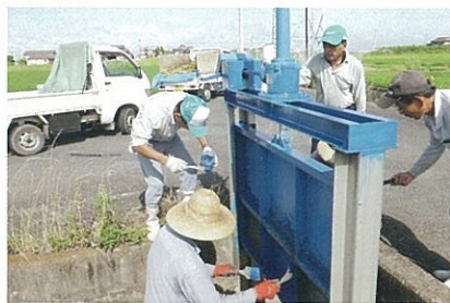
ゲートのサビ落とし塗装
