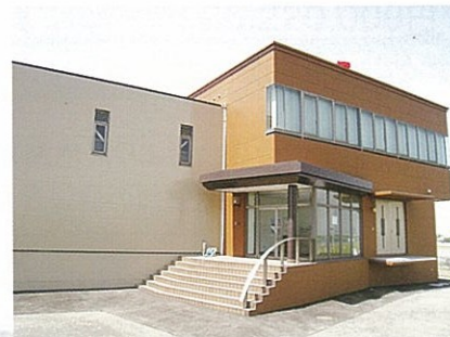
六間堰管理所・倉庫の塗装
