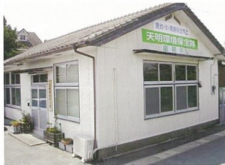
天明環境保全隊事務所
