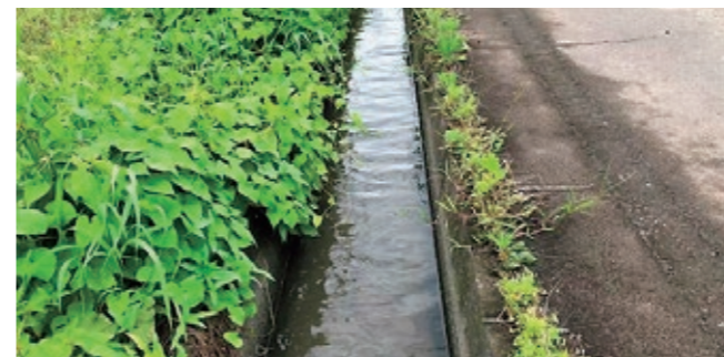
水路畔に繁茂している雑草
